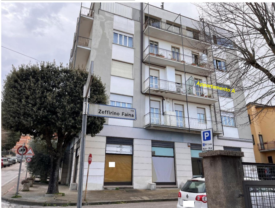
Foto 1, prospetto Nord Est della palazzina residenziale, da Via F.lli Ceci (SS317) verso Via Zeffirino Faina, da Est verso Ovest
