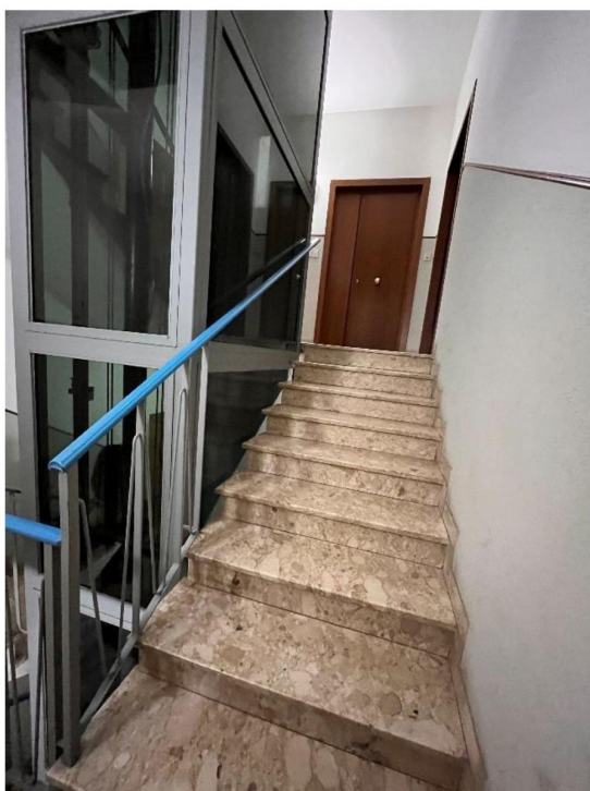
Foto 3, scale condominiali verso ingresso appartamento A
