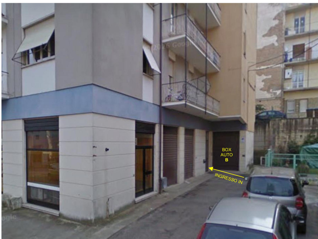
Foto 2, angolo Est palazzina resid.le, da Via Z. Faina verso ingresso condominiale IN e box auto B
